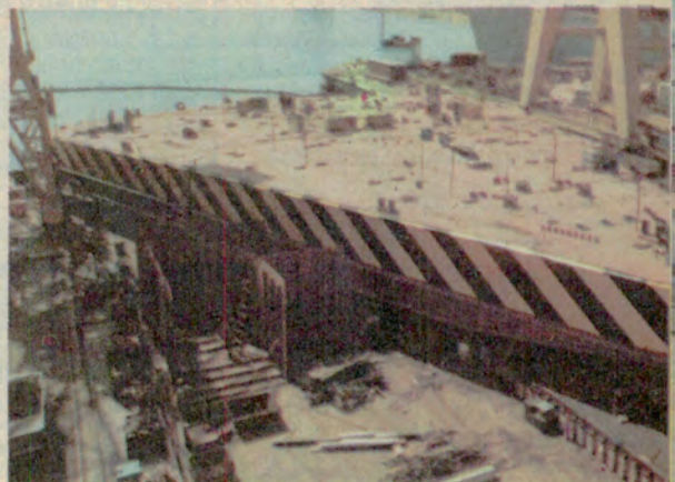
La construcción de grandes una de las actividades
