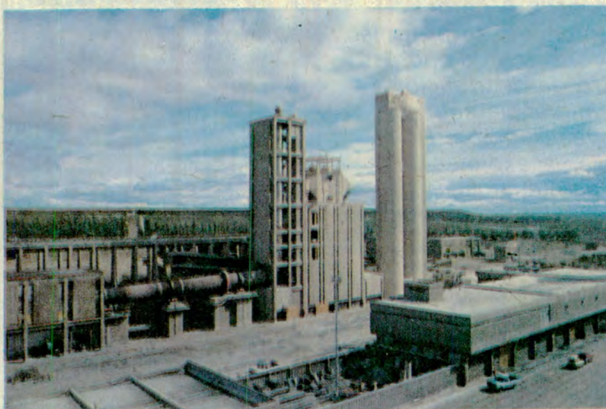
Cementera Patagónica, moderna planta en que se utiliza piedra caliza extraída en El Salitral, cantera situada a 15 kilómetros.
